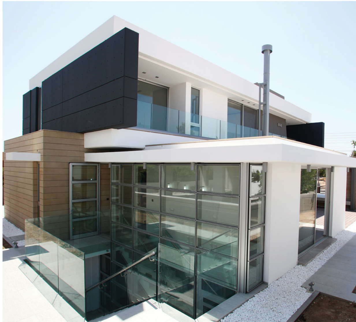
📍 ΑΝΕΓΕΡΣΗ ΚΑΤΟΙΚΙΑΣ | ΛΕΥΚΩΣΙΑ
