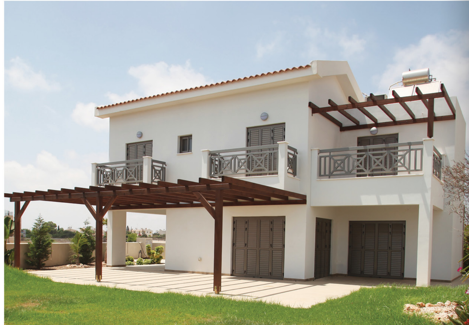
📍 ΑΝΕΓΕΡΣΗ ΚΑΤΟΙΚΙΑΣ | ΑΓΙΑ ΘΕΚΛΑ, ΑΜΜΟΧΩΣΤΟΣ
